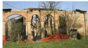
Sopra: il progetto di recupero del complesso colonico all'Albanus. Sotto: l'attuale attuale del complesso.
